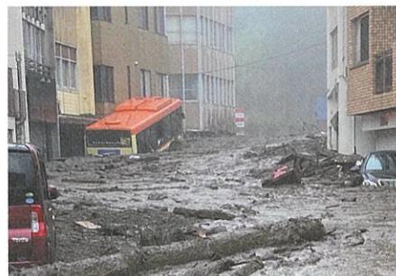
▲大雨災害による甚大な被害(熱海市)
