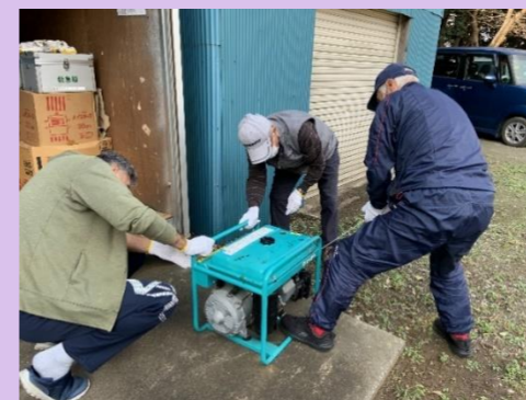
発電機点検 10月25日(土) 4人 12月12日(火) 4人 2月 3日(土) 3人
